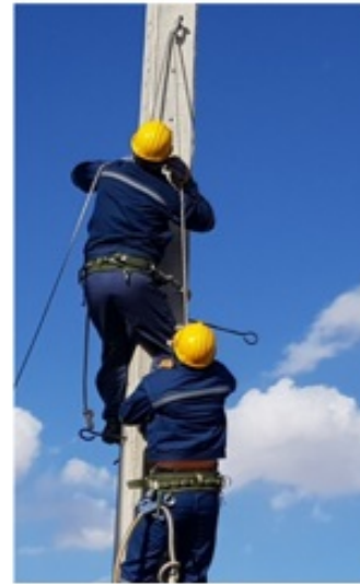
انتقال مصدوم از بالای پایه به پائین بدون هارنس (پایه بدون کنسول)
