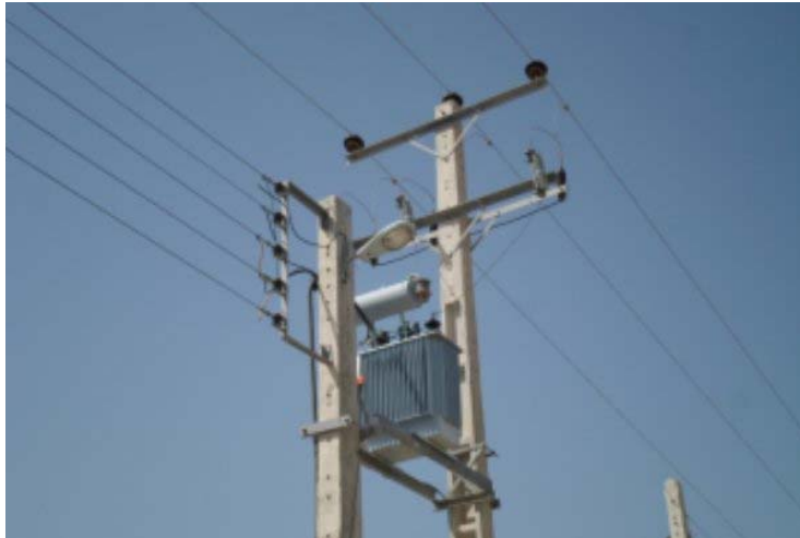
لیست قطعات یک پست هوایی ۲۰ کیلوولت
